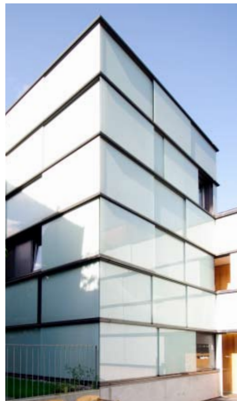
Let og højisoleret træfacade med glas som regnskærm Sebastianstrasse, Dornbirn Baumschlagel & Eberle, 2002
